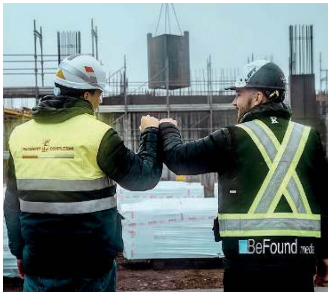
La visita ai cantieri. Mattia Facchetti con il canadese Naythan Lange
