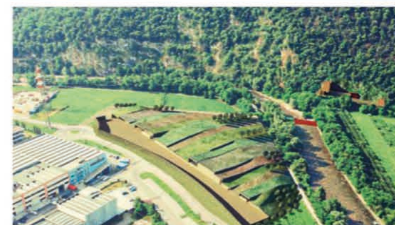
DEPURATORE PER ACQUE REFLUE CIVILI
