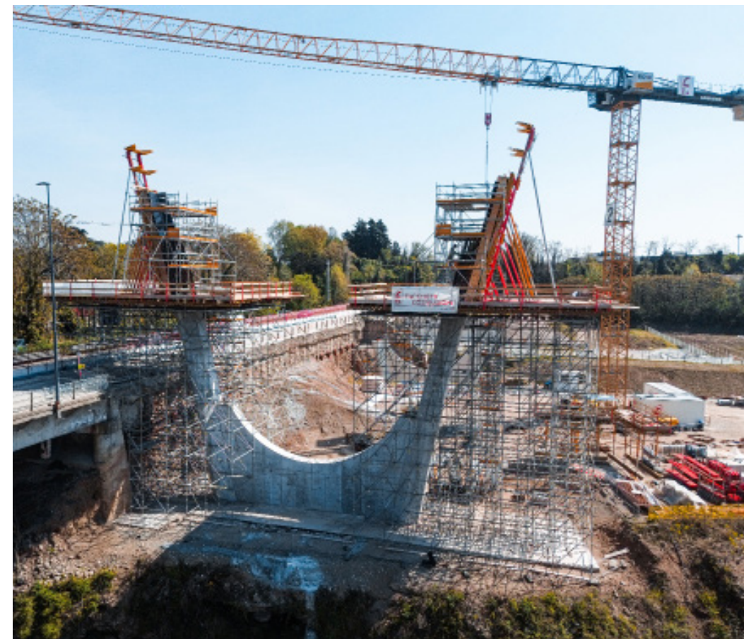
Realizzazione delle pile in cemento armato, caratterizzate da una forma rastremata, attraverso l'utilizzo di casseforme speciali.
