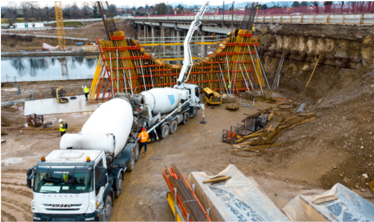
Messa in opera delle armature progettate con elevata densità e con forme non convenzionali, adattate alle geometrie delle pile.
