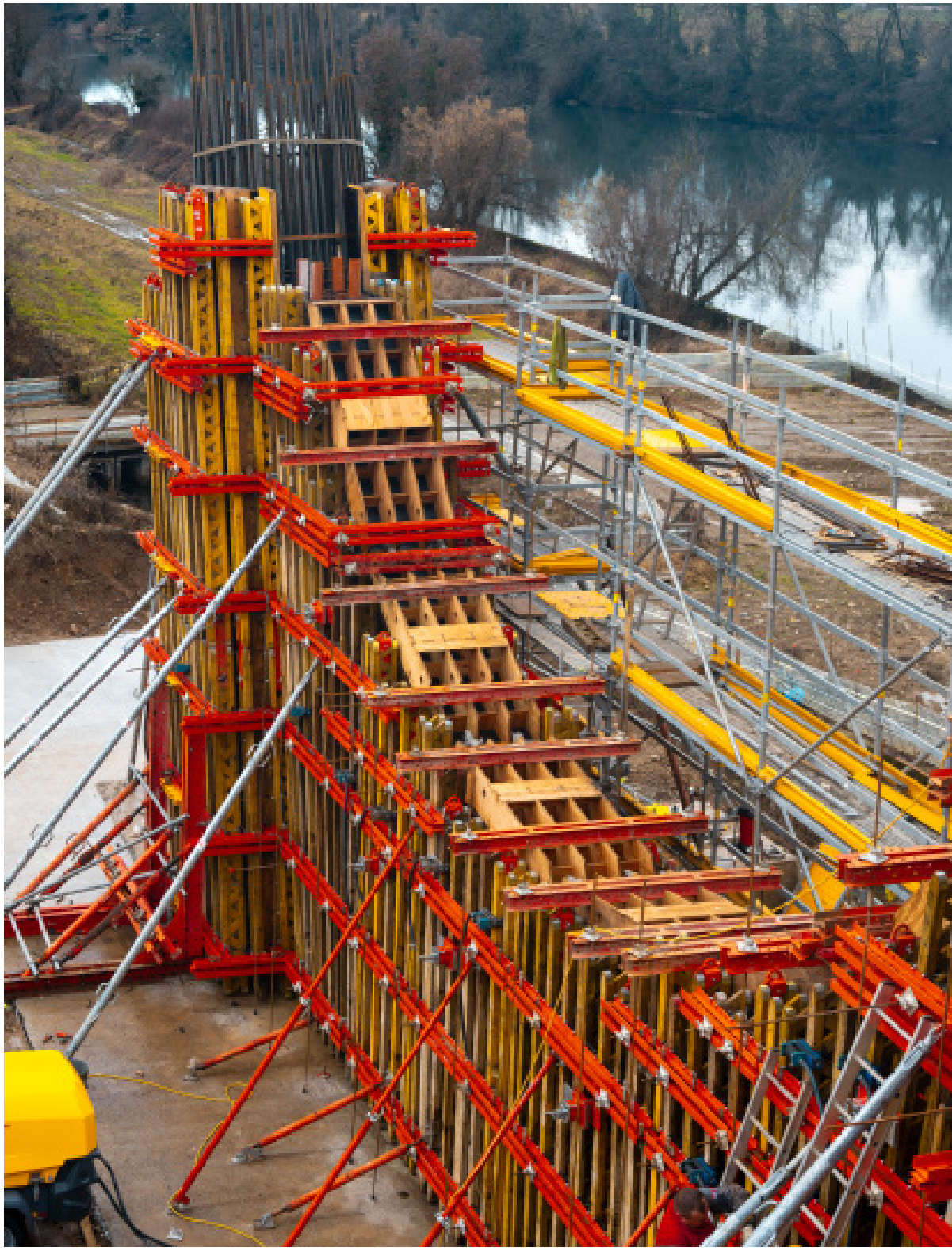
Messa in opera delle casserature speciali su misura per la realizzazione delle quattro pile.
