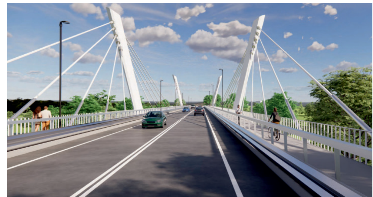
Render della campata del ponte sorretta da un sistema di 40 stralli ancorati alle due antenne laterali poggianti fuori dall'alveo del fiume.
