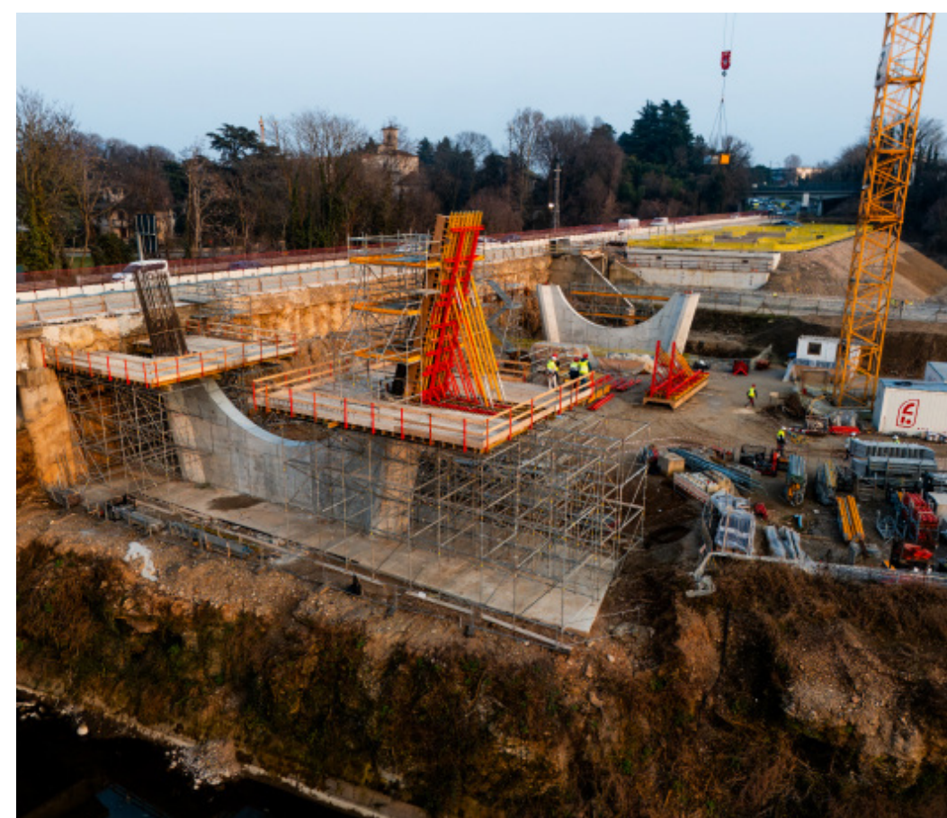
Realizzazione delle pile in cemento armato, caratterizzate da una forma rastremata, attraverso l'utilizzo di casseforme speciali.
