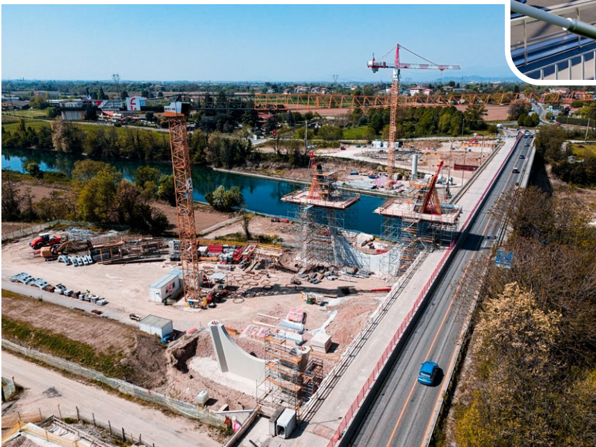
Dettagli della fase di costruzione di una pila del ponte con l'utilizzo di sistemi di cassetteria speciali, progettati e realizzati su misura per ciascun elemento strutturale
