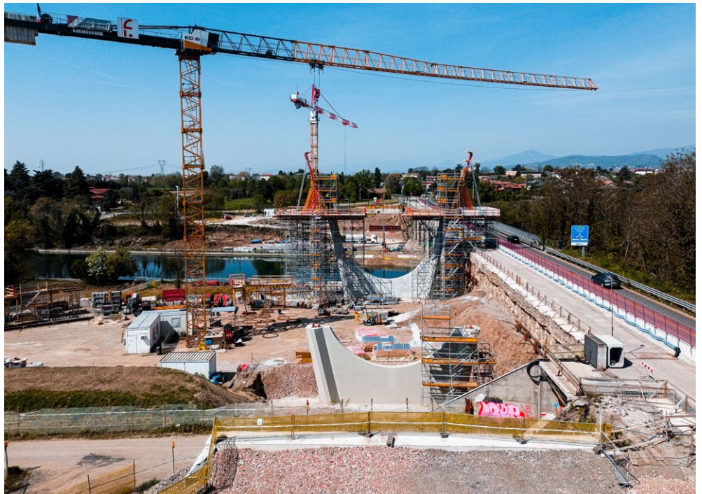
Avanzamento dei lavori di cantiere per la realizzazione delle strutture in misto acciaio-calcestruzzo che costituiscono l'ossatura dell'opera infrastrutturale
