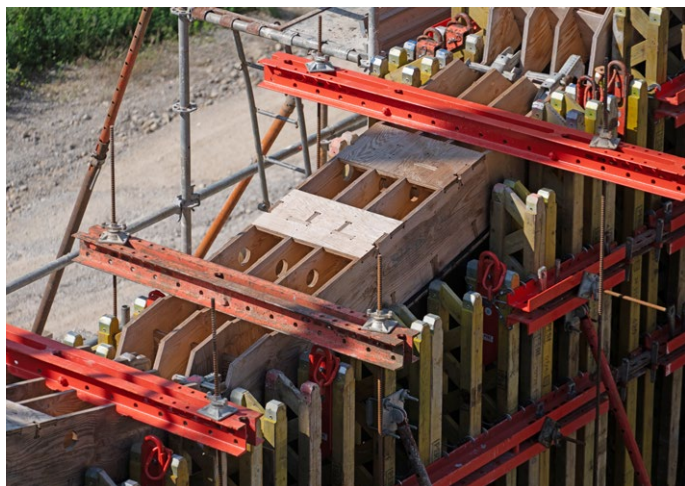
Un particolare delle casseforme PERI per il getto della pila
