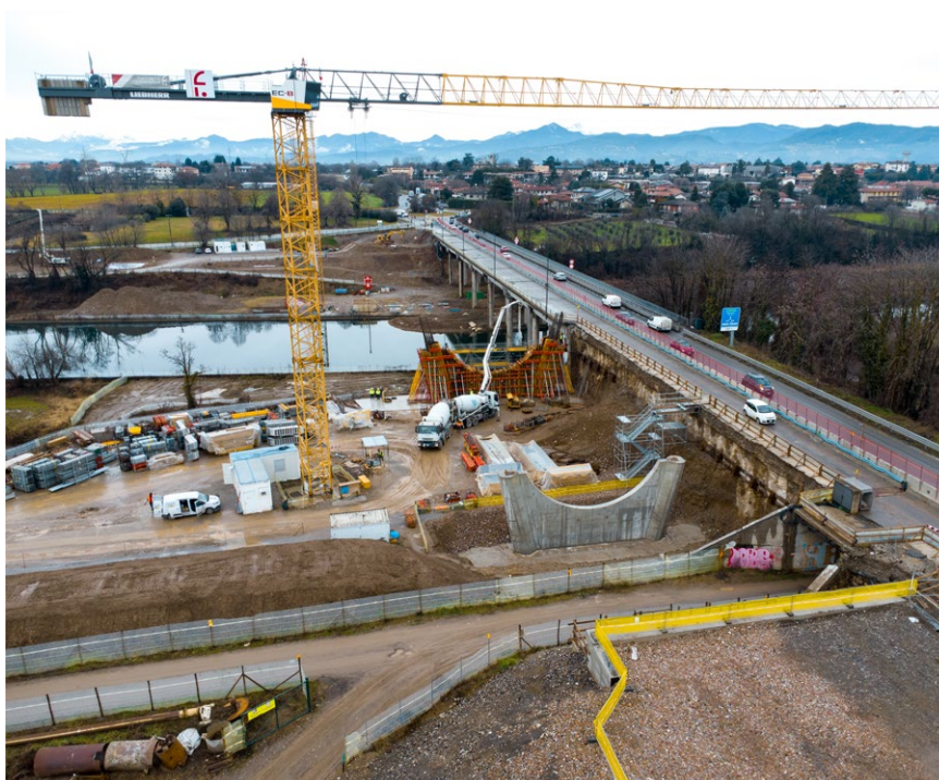
Dettagli della fase di costruzione di una pila del ponte con l'utilizzo di sistemi di cassetta speciale, progettati e realizzati su misura per ciascun elemento strutturale
