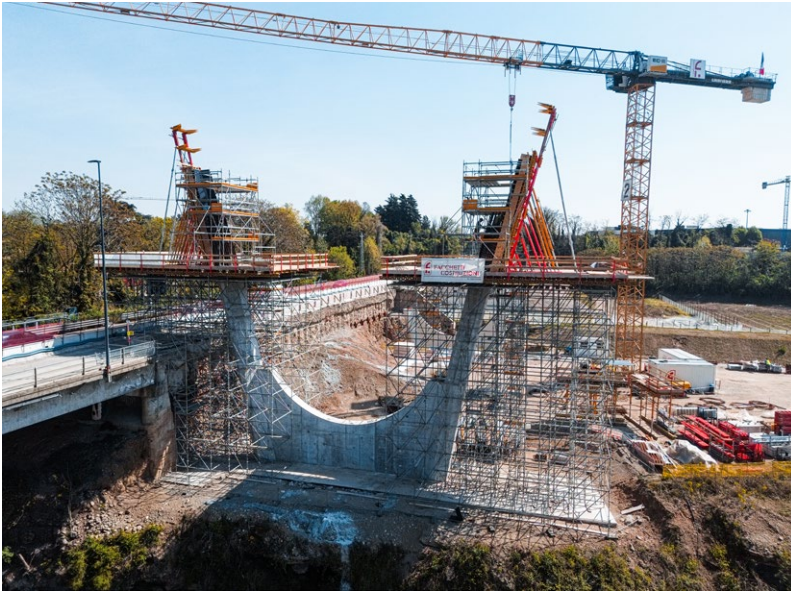
Le soluzioni adottate prevedono tecniche costruttive efficienti e a basso impatto, con particolare attenzione alla gestione logistica del cantiere e alla tutela del contesto ambientale circostante
