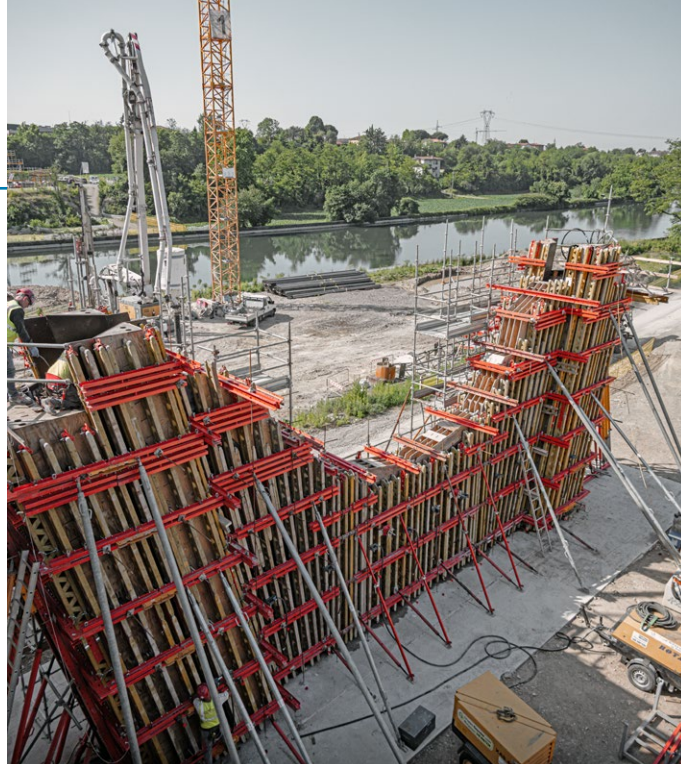
La struttura di casseforme per il getto in opera della pila
