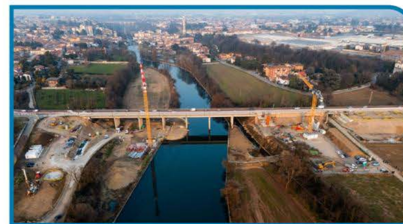
2. I lavori per il nuovo ponte sulla SP BS 573 procedono, sono state completate le basi delle pile principali
