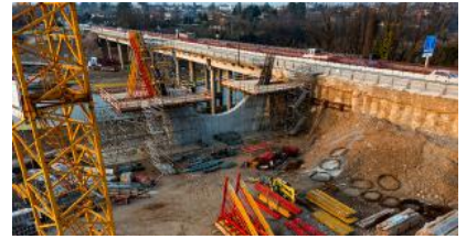
L'imponente intervento I lavori al ponte di Palazzolo
